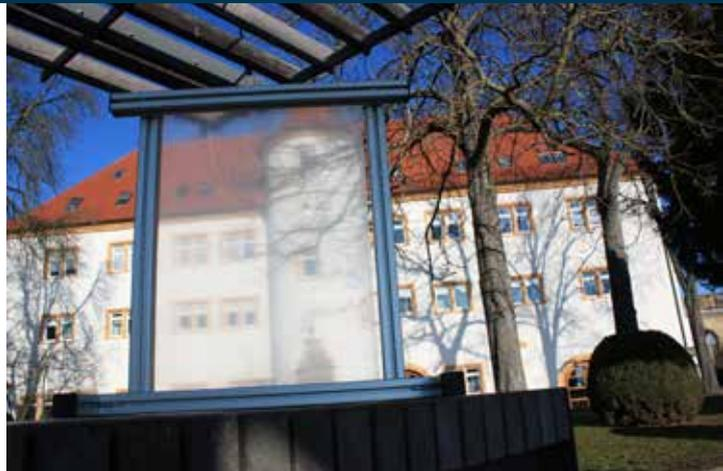
*Das textile Fassadenelement reguliert die Licht- und Strahlungsdurchlässigkeit.*
