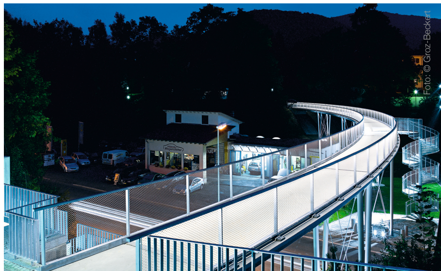
Textilbewehrte Betonbrücke in Baden-Württemberg
