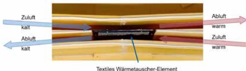
Detail eines eingebauten textilen Wärmetauscher-Elements
