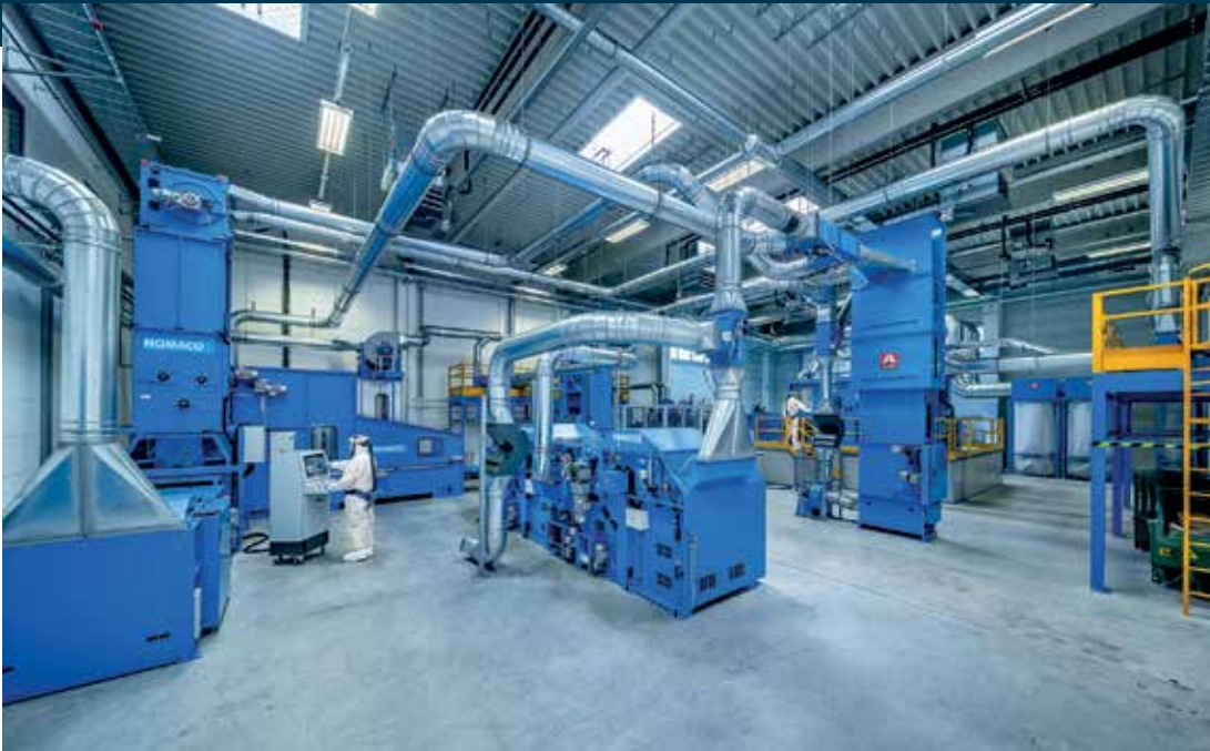
Carbonfaservliesstoffanlage im Zentrum für Textilien Leichtbau am STFI.
