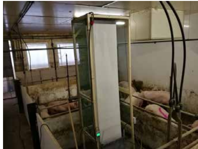
Die Anlage entfernt zuverlässig Ammoniak aus der Luft in Schweineställen.
